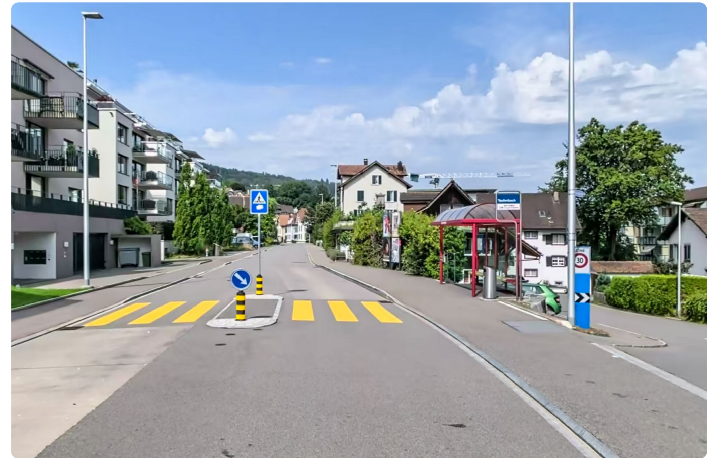
Teufenbach bus stop
