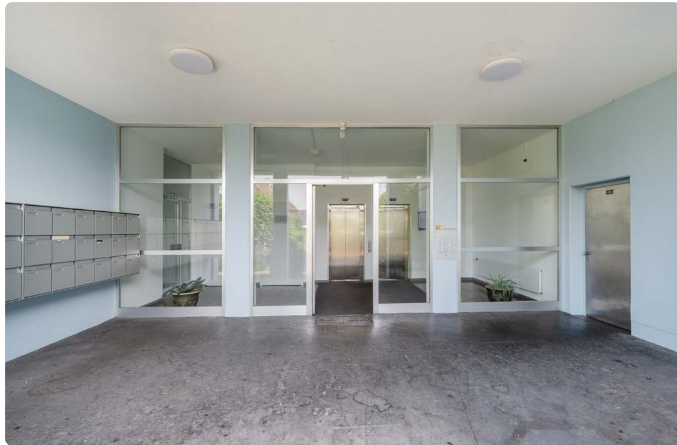
Eingangsbereich mit zwei Liften
