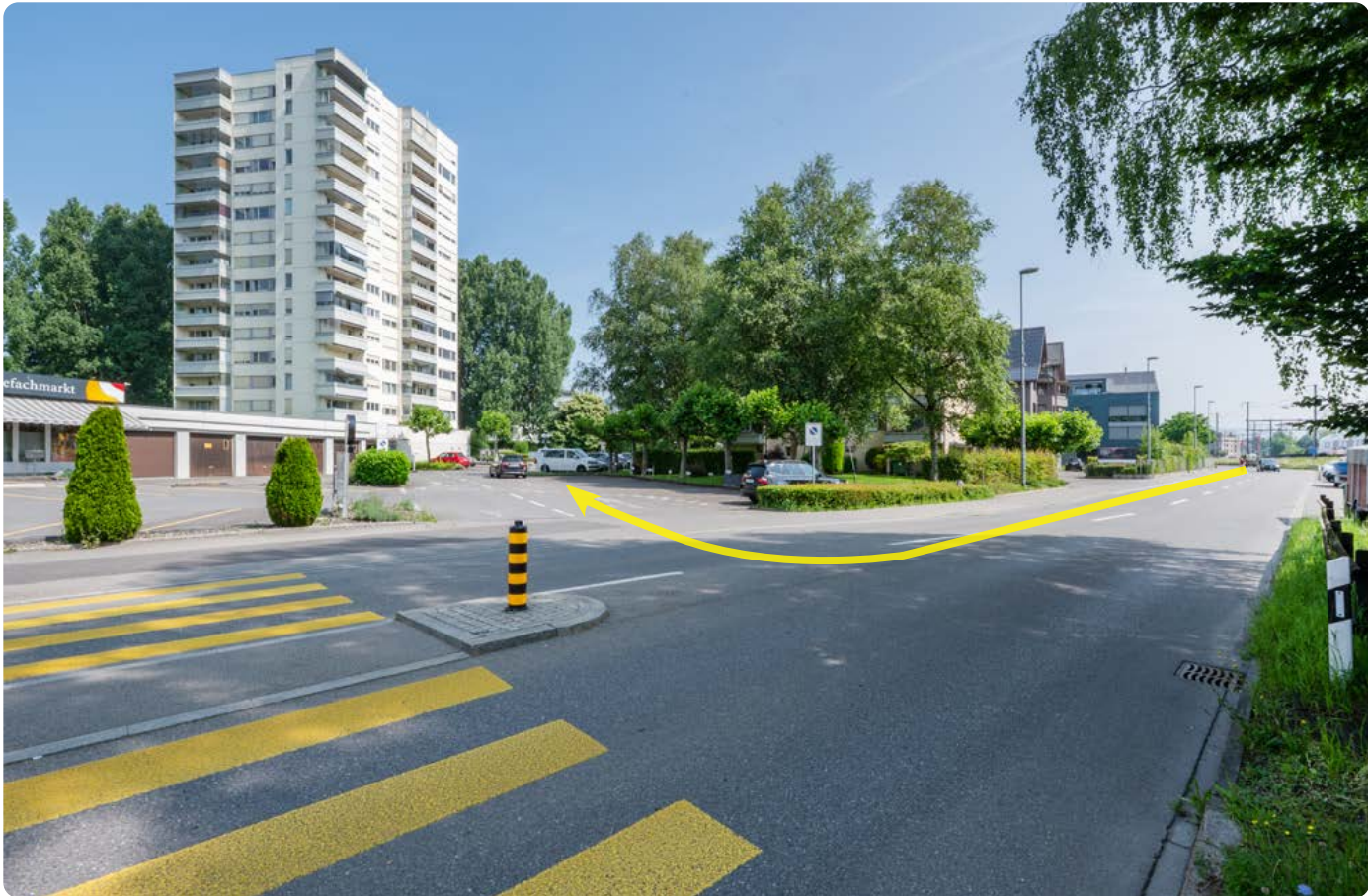
Zufahrt von der Luzernerstrasse
