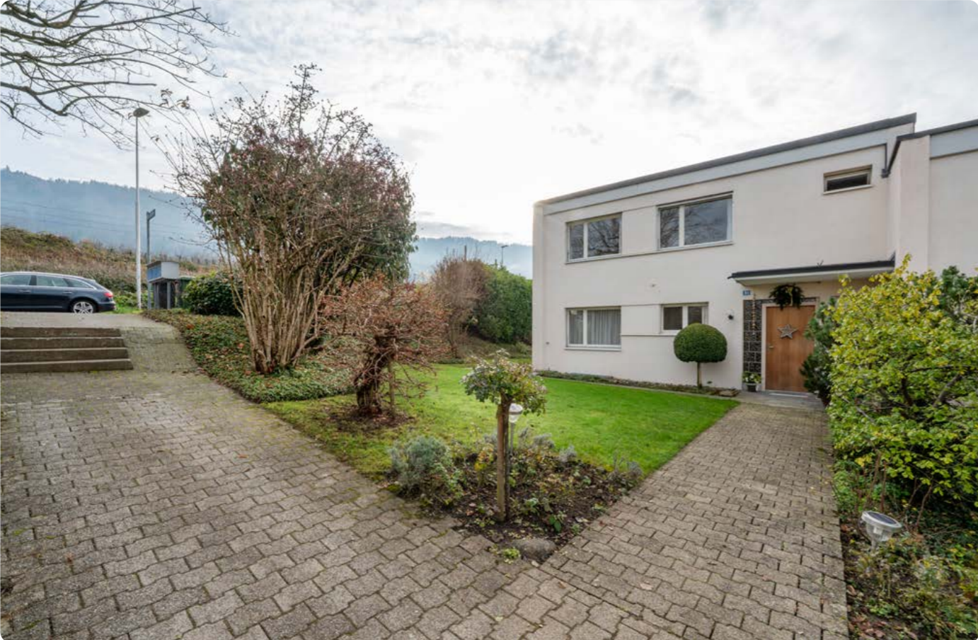
Zugangsbereich zum Reiheneckhaus
