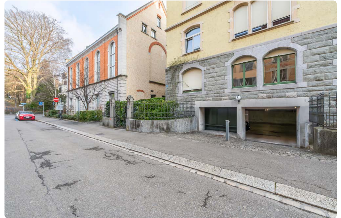
Tiefgarageneinfahrt an der Cäcilienstrasse
